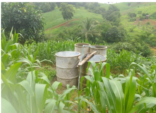
๓) งานวางท่อส่งน้ำแยกเข้าถังสำรองน้ำ ๓ (ถังเดิม) ระยะทาง ๒๕ เมตร
