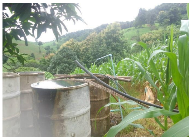
๔) งานวางท่อส่งน้ำจากถังสำรองน้ำ ๑ ถึง ถังสำรองน้ำ ๔ (ถังเดิม) ระยะทาง ๓๕๐ เมตร
