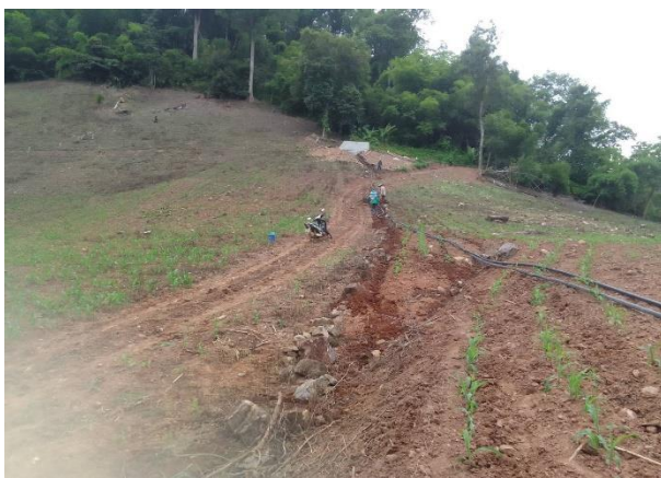
๔) งานวางท่อส่งน้ำจากถังสำรองน้ำ ๑ ถึง ถังสำรองน้ำ ๔ (ถังเดิม) ระยะทาง ๓๕๐ เมตร
