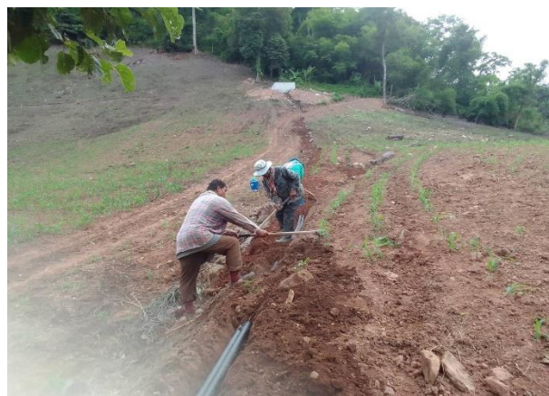
๔) งานวางท่อส่งน้ำจากถังสำรองน้ำ ๑ ถึง ถังสำรองน้ำ ๔ (ถังเดิม) ระยะทาง ๓๕๐ เมตร
